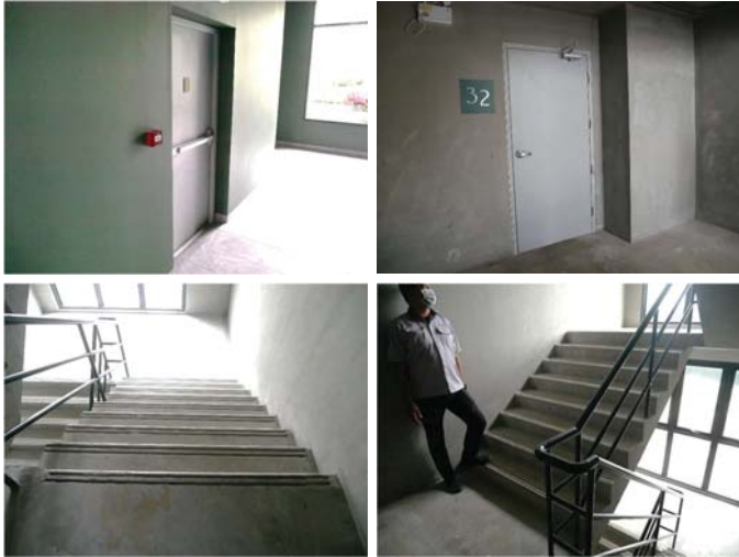
ภาพบันไดหนีไฟและเส้นทางหนีไฟ มีระบบแสงสว่าง ไม่มีสิ่งกีดขวาง ผนังหรือประตูทำด้วยวัสดุทนไฟ สามารถใช้หนีภัยในการฉุกเฉินได้
