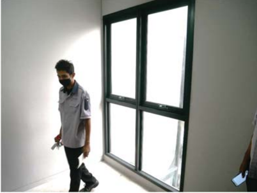
พิจารณาการเปิดหน้าต่างที่บริเวณ โถงลิฟต์ดับเพลิงทุกชั้นเนื่องจากหน้าต่างใช้แทนระบบพัดลมอัดอากาศ
