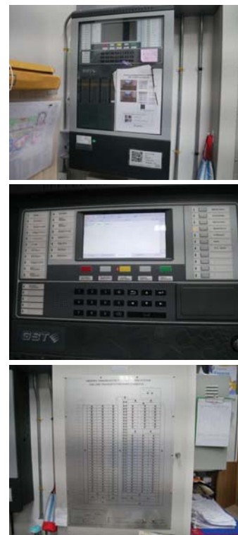
ภาพระบบสัญญาณแจ้งเหตุเพลิงไหม้ ตู้ FCP และ Graphic Annunciator มีการตรวจสอบเบื้องต้นจากทางฝ่ายอาคาร
