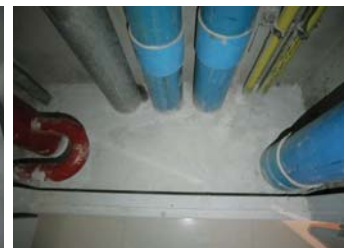
ภาพการปิดช่องเปิดระหว่างชั้น (ขาร้ปงานระบบ) ป้องกันการแพร่กระจายควันไฟ
