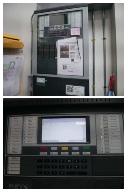
ตรวจสอบและแก้ไขระบบแจ้งเตือนเพลิงไหม้ให้พร้อมใช้งานทุกจุด (ชิ้นสถานะ Trouble)
